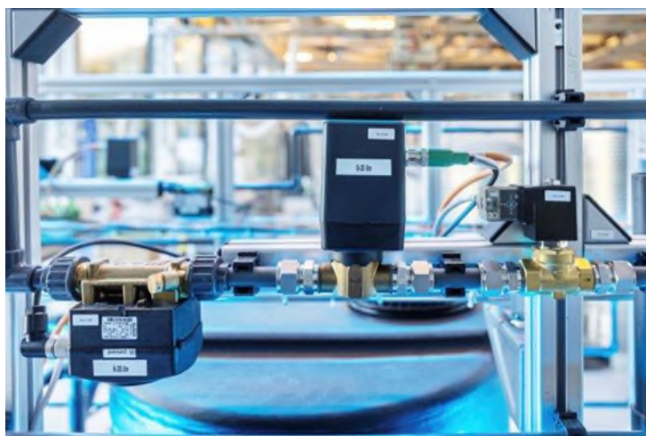
Figuur 19: Voorbeeld van een regelbare kraan met drie componenten: een lokale flowmeter (links), een variabele klep (midden) en een binaire klep (rechts). De bijbehorende onderdelen zijn van messing. Foto is gemaakt door Herbert Wiggerman in opdracht van Techniek Nederland.
